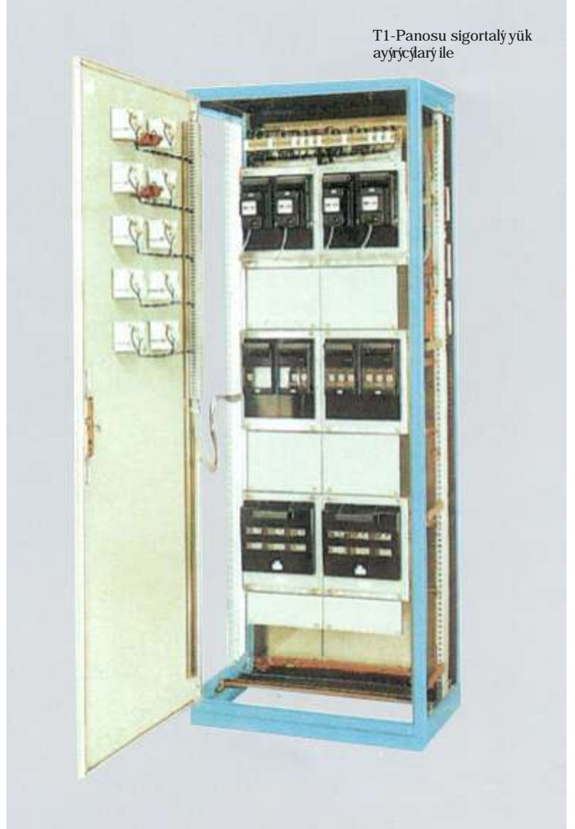
Sigortalı yük ayırıcısı montaj grubunun örtüsü sökülüp görünüşü
