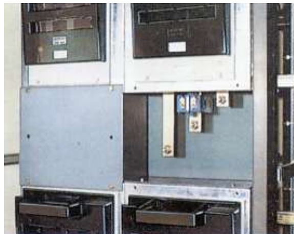
Sigortalı yük ayırıcısı montaj grubunun örtüsü sökülüp görünüşü
